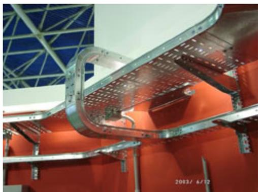
"S5-КОМБИТЕК" - несущая система для открытой проводки в промышленных и подсобных помещениях, а также в других помещениях большой площади. Состоит из перфорированных и неперфорированных лотков, крышек из оцинкованной стали и аксессуаров. Основная функция системы металлических лотков – постоянно удерживать и защищать кабель. При использовании неперфорированных лотков, крышек, а также специальных пластин на стыках обеспечивает степень защиты IP 44.
